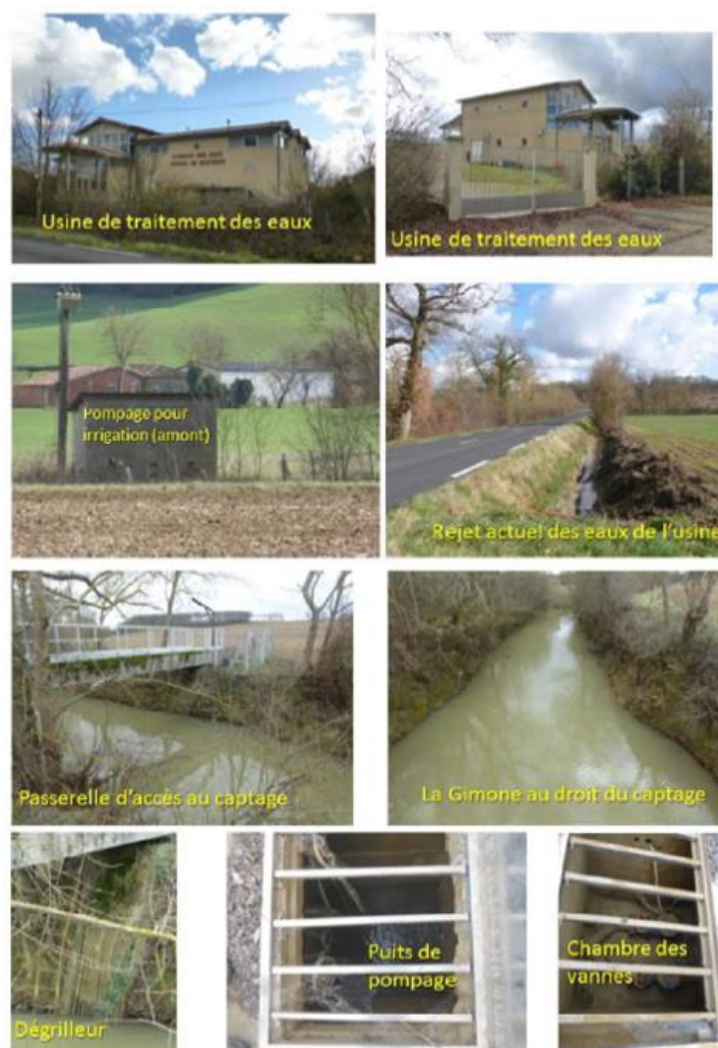
Figure 4 : Planche photographique du site – janvier 2016
